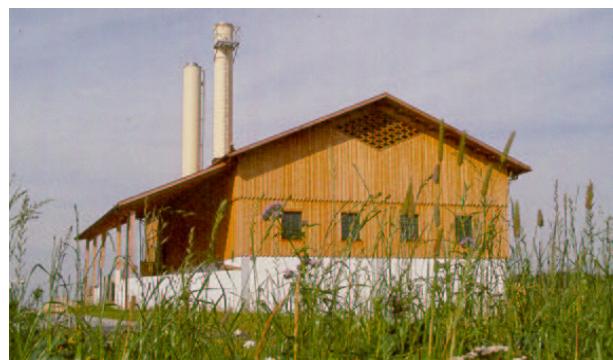
Abbildung 3: Außenansicht des Biomasseheizwerkes Sibyllenbad in Neualbenreuth (Quelle: C.A.R.M.E.N.)
